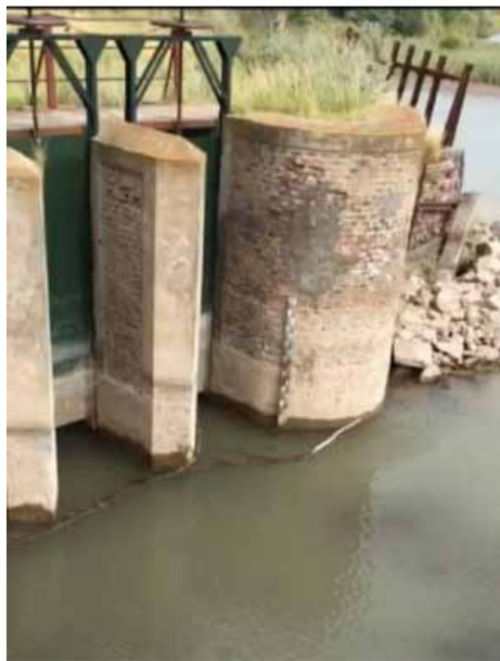
Imagen de la toma aguas abajo.
